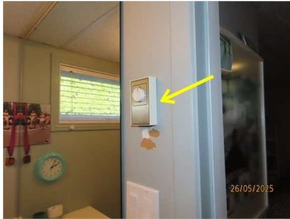
Thermostat mécanique désuet
