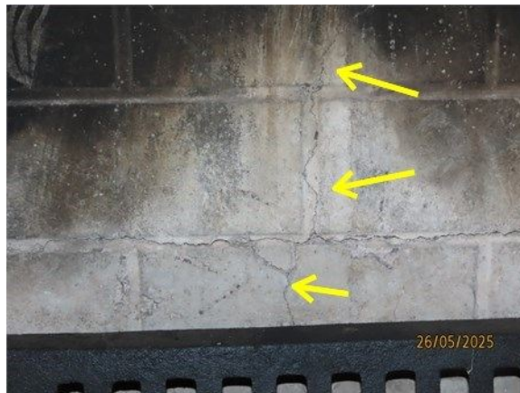
Brique fissurée
