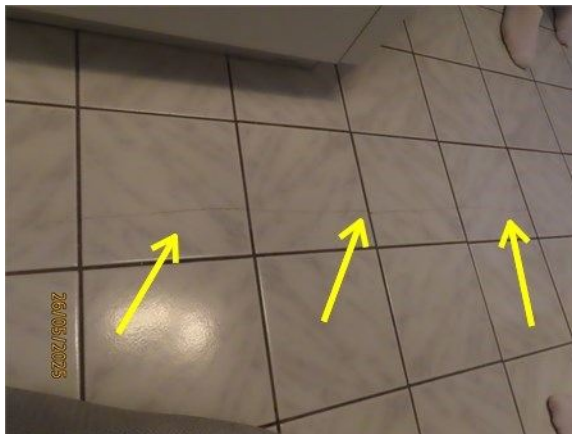
Fissures dans les céramiques
