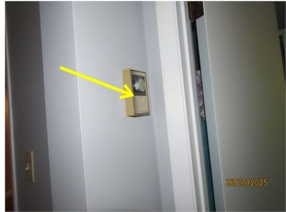
Thermostat mécanique désuet
