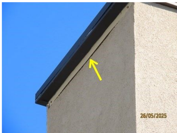
Joint de scellant manquant
