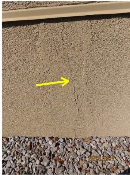
Fissure dans le crêpi à colmater côté droit
