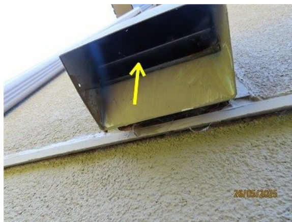
Le clapet reste ouvert
