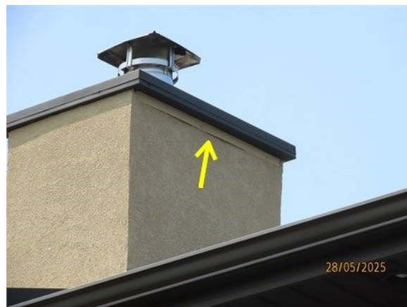
Joint de scellant manquant
