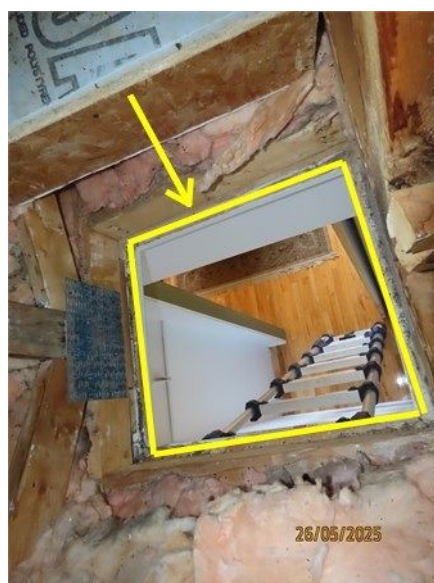
Il manque le joint d'étanchéité
